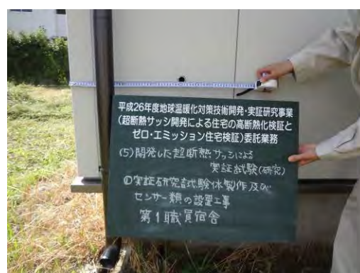
写真 6.5.1-2 換気孔施工 試験体1 通気孔（給気孔外壁側）
