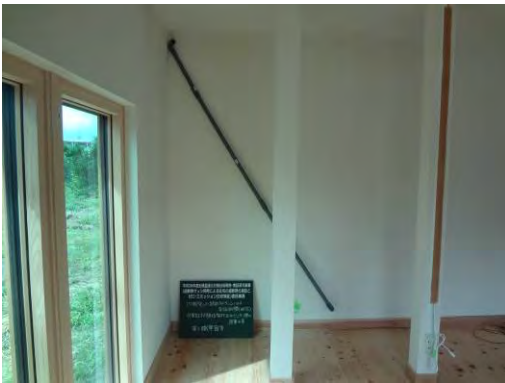
写真6.5.1-7 試験体1 排気配管施工
