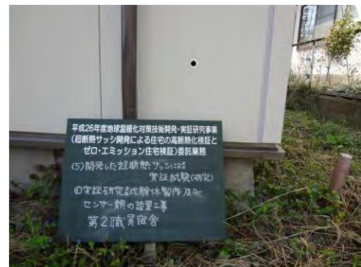
写真6.5.1-10 換気孔施工 試験体2 通気孔(給気孔外壁側)
