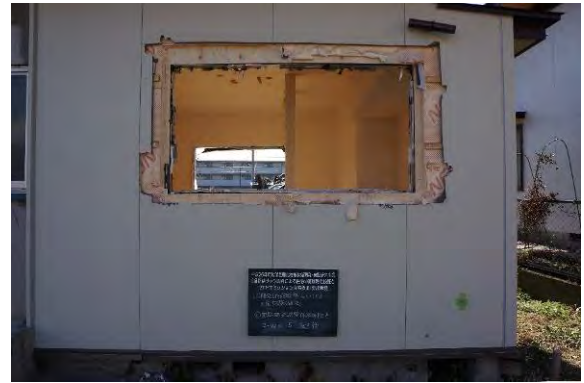
写真 6.5.3.2-6 試験体 2 (取外し 外部状況)
