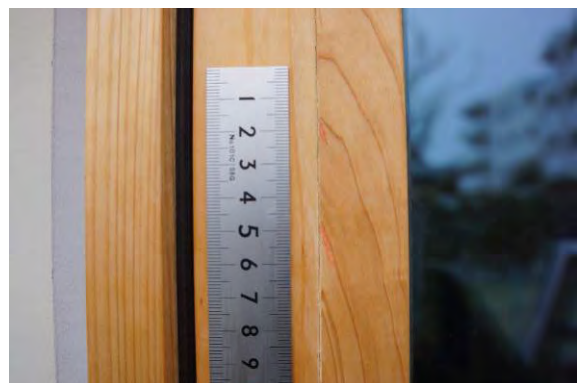
写真6.5.3.1-32 3-WW-4 (実証試験体3) 外部障子割れ
