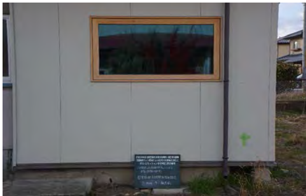
写真6.5.3.1-2 5 3-WW-3 (実証試験体3) 外部
