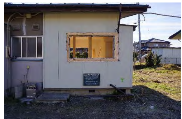
写真 6.5.3.2-10 試験体 3 (取外し 外部状況)
