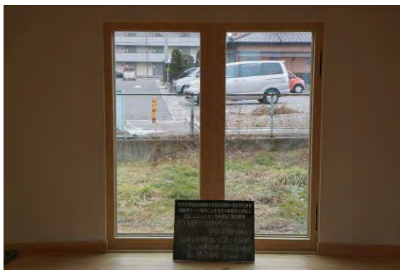
写真6.5.3.1-37 表面変色の確認（実証試験体2） 2-WW-3
