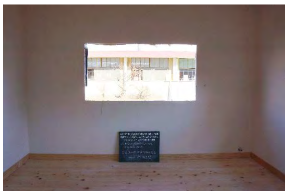
写真6.5.3.2-3 試験体1 (取外し 内部状況)
