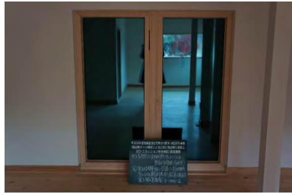
写真6.5.3.1-2 4 3-WW-2 (実証試験体3) 内部
