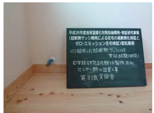
写真6.5.1-16 換気孔施工 試験体3 通気孔（給気孔内壁側）
