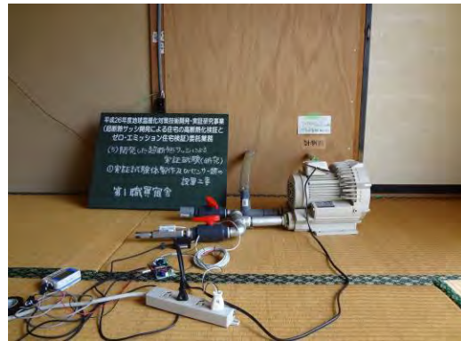
写真6.5.1-6 試験体1 換気システム設置
