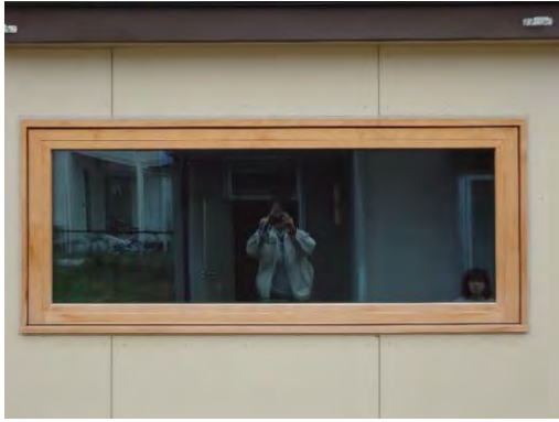
写真6.5.3.1-2 1 2-WW-5 (実証試験体2) 外部
