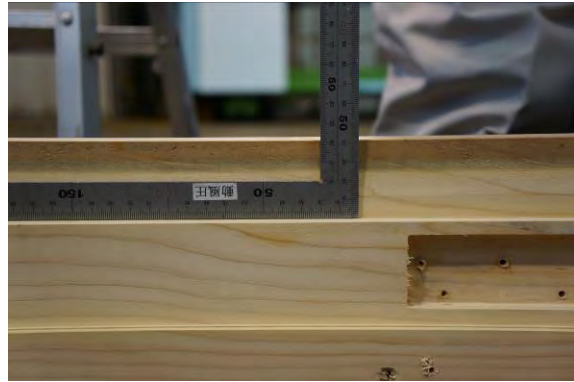
写真6.5.3.1-34 表面変色（実証試験体2）
