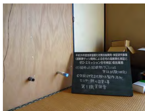
写真 6.5.1-4 換気孔施工 試験体1 通気孔（排気孔外壁側）
