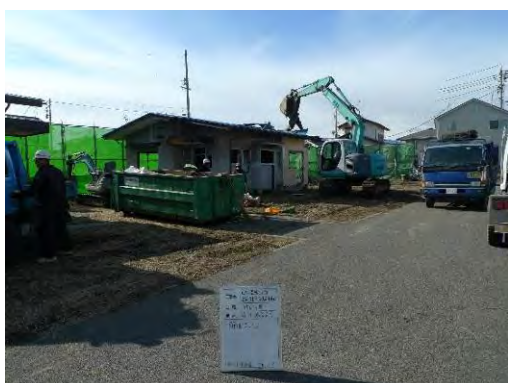
写真 6.5.4.1-5 試験体3解体撤去
