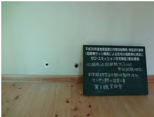
写真6.5.1-5 換気孔施工 試験体1 通気孔(排気孔内壁側)
