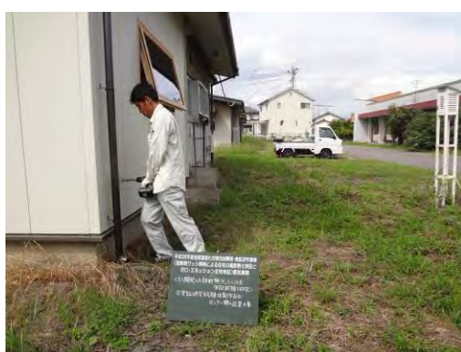
写真 6.5.1-1 換気孔施工
