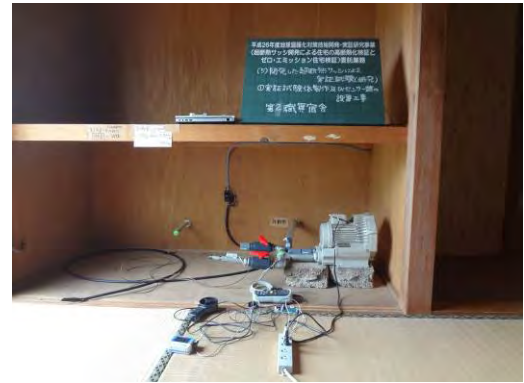
写真6.5.1-14 試験体2 換気システム設置
