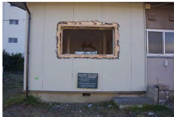
写真6.5.3.2-2 試験体1 (取外し 外部状況)
