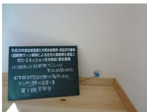
写真 6.5.1-3 換気孔施工 試験体1 通気孔（給気孔外壁側）
