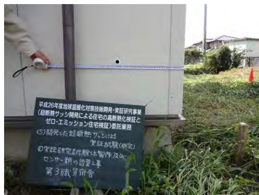
写真6.5.1-15 換気孔施工 試験体3 通気孔（給気孔外壁側）
