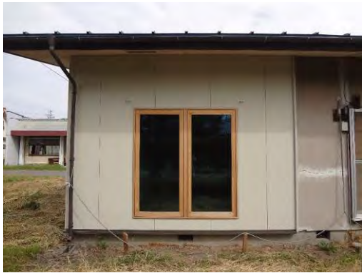
写真6.5.3.1-2 3 3-WW-2 (実証試験体3) 外部
