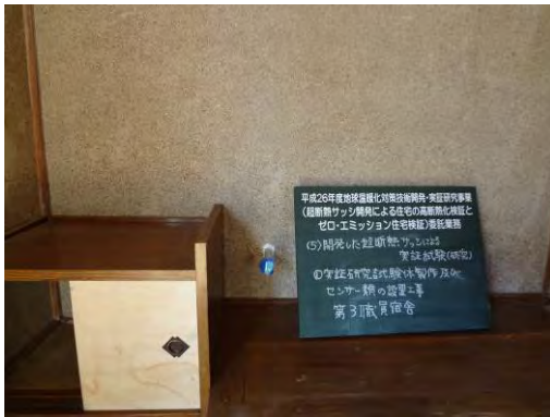
写真6.5.1-17 換気孔施工 試験体3 通気孔 (排気孔外壁側)
