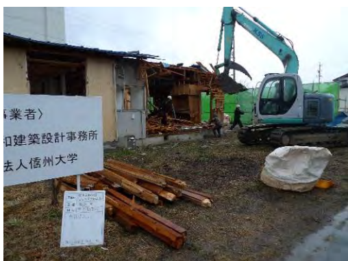
写真 6.5.4.1-3 試験体1解体撤去
