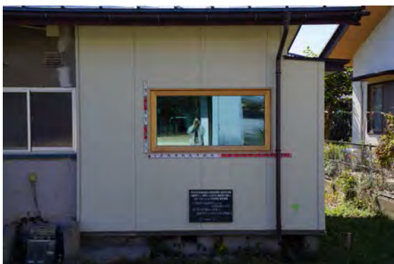
写真 6.5.3.2-9 試験体 3 (室外側)
