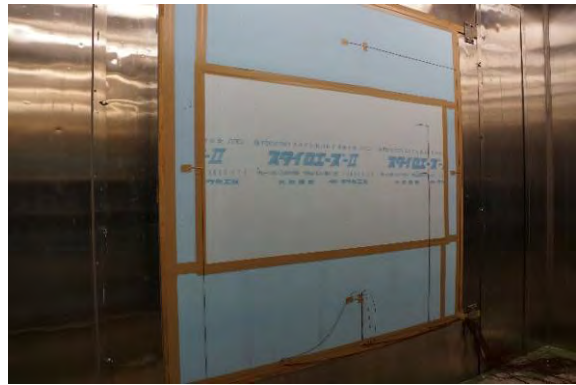
写真6.5.3.2-15 校正板計測（室外側）
