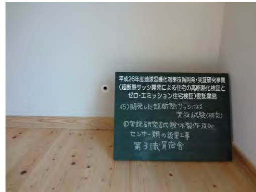
写真6.5.1-18 換気孔施工 試験体3 通気孔 (排気孔内壁側)
