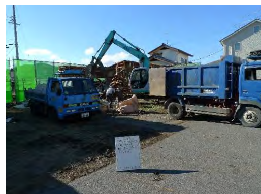
写真 6.5.4.1-4 試験体2解体撤去
