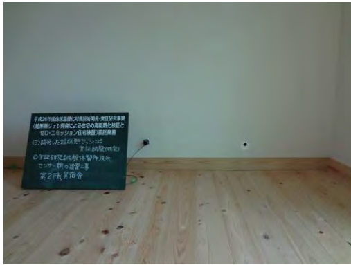
写真6.5.1-13 換気孔施工 試験体2 通気孔（排気孔内壁側）
