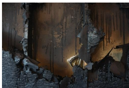
試験終了 加熱面燃え抜き（内装材裏面）
