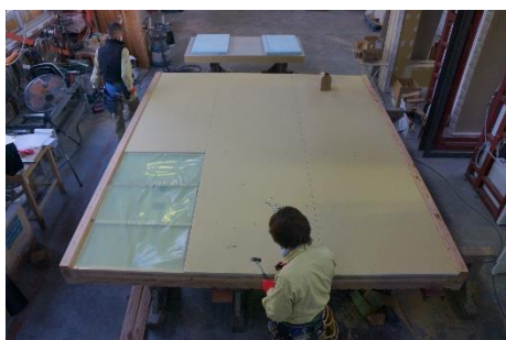
13. 内装材取付け (下張り材)
