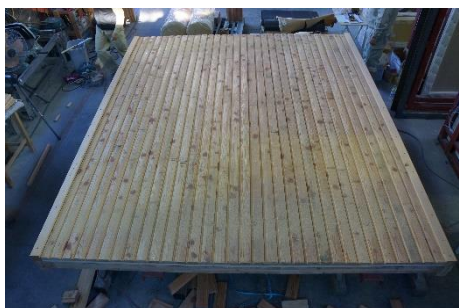
7. 外装材取付け
