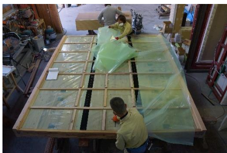
11. 内部胴縁取付け
