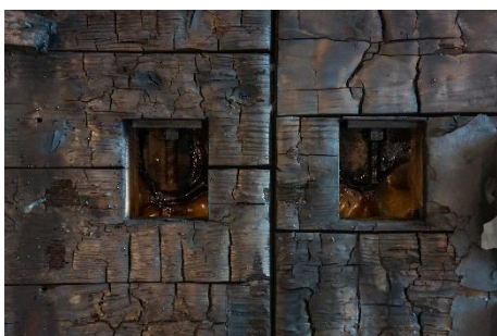
試験終了 金物 直行集成板欠損部 取付け金物箱抜き
