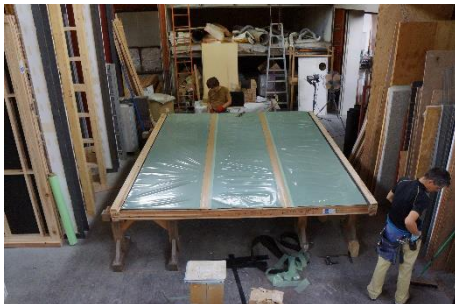
5. 下張材取付け
