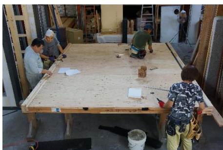
3. 下張材取付け
