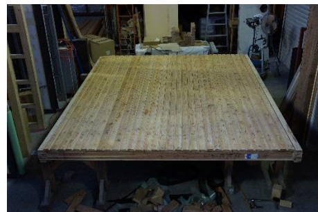
8. 外装材取付け
