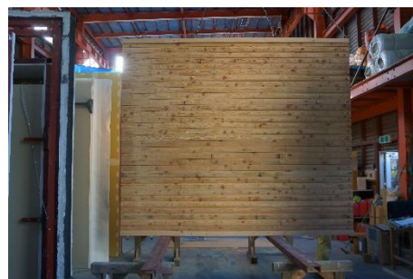
8. 外装材取付け完了
