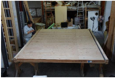
3. 下張材取付け
