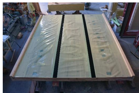
10. 気密フィルム 2 取付け完了
