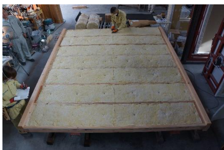
5. 外断熱材取付け
