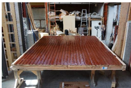
12. 外装材木材保護塗料塗装
