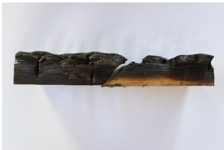
試験後 外装材目地部分
