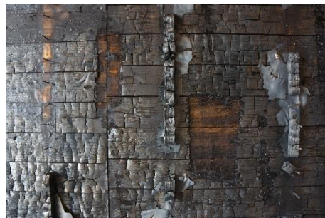
試験終了 試験体表面 直行集成板燃え込み確認
