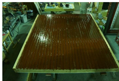
16. 外装材木材保護塗料塗装付完了
