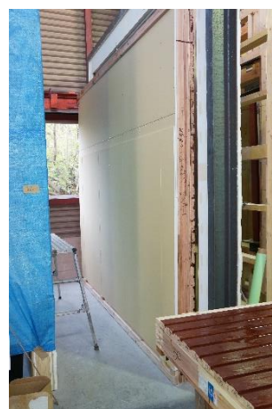
12. 内装材取付け (上張り材)
