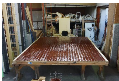
14. 木材保護塗料塗装完了
