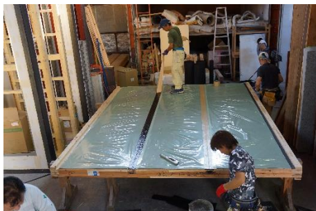
5. 下張材取付け
