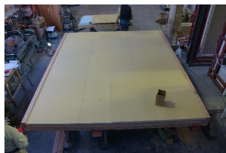
14. 内装材取付け (上張り材)
