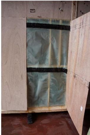
試験終了 内装材下 気密フィルム
