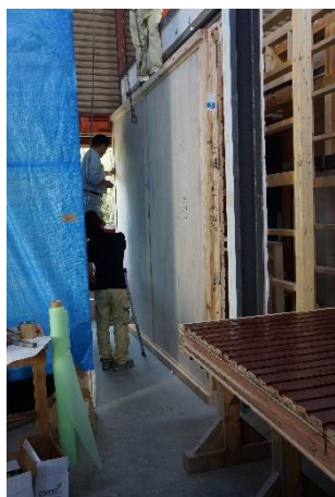
11. 内装材取付け
