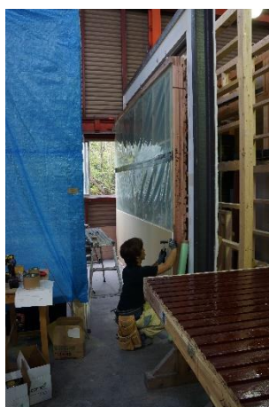
11. 内装材取付け (下張り材)
