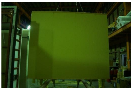
15. 内装材取付け完了
