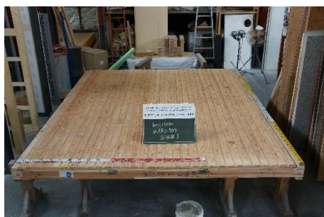
8. 外装材取付け
